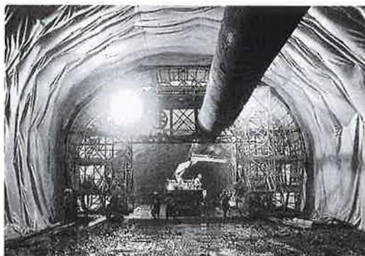
タイラムトンネル工事現場
