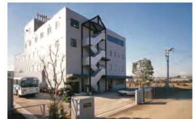
1989年 本社工場移転・統合 本社工場(神奈川県綾瀬市)(現在の所在)
